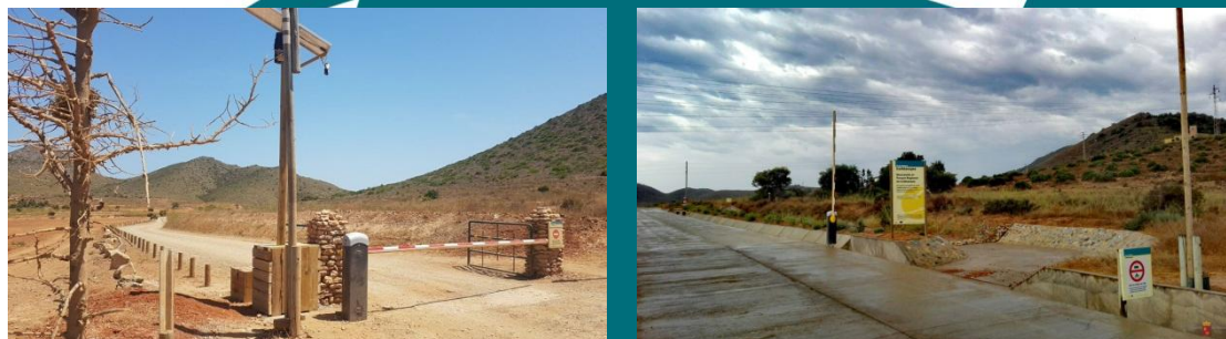
Foto 20 y 21. Barreras electrónicas instaladas en La Boquera y en la entrada principal.
