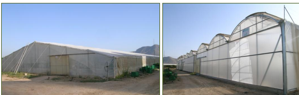
Fotos 5 y 6. Invernaderos tipo “capilla” (izq.) y tipo “multitúnel” (dcha.).
