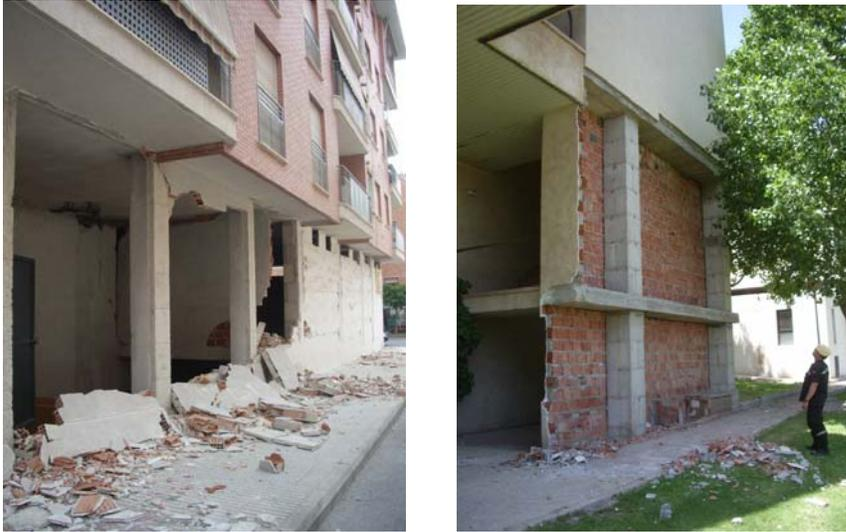
Fig B11 Daños por cortante en el cerramiento no estructural de planta baja de un edificio de viviendas. El cerramiento ha entrado en carga resistiendo los esfuerzos horizontales de la estructura, por lo que muestra los mismos mecanismos de daño que las estructuras murarias, fallando por cortante con grietas en forma de aspa.
