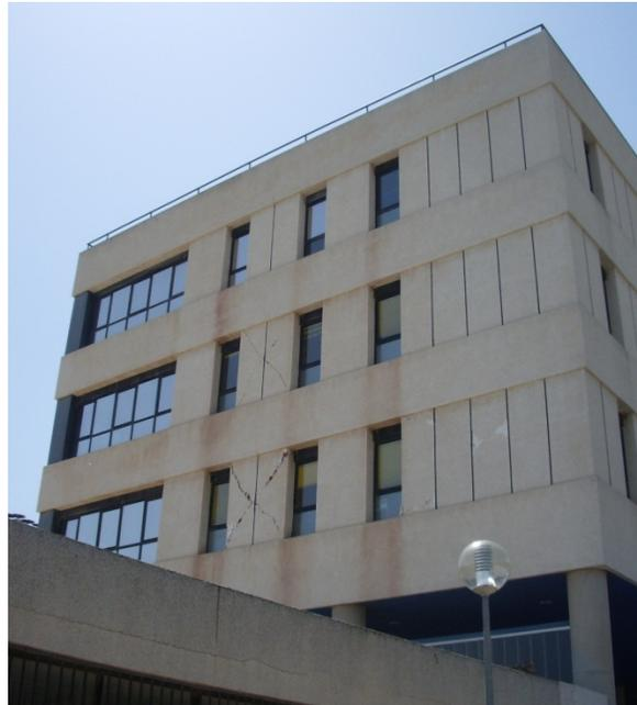
Fig B26 Fallo de cerramientos no estructurales bloqueando las salidas de edificios o locales
