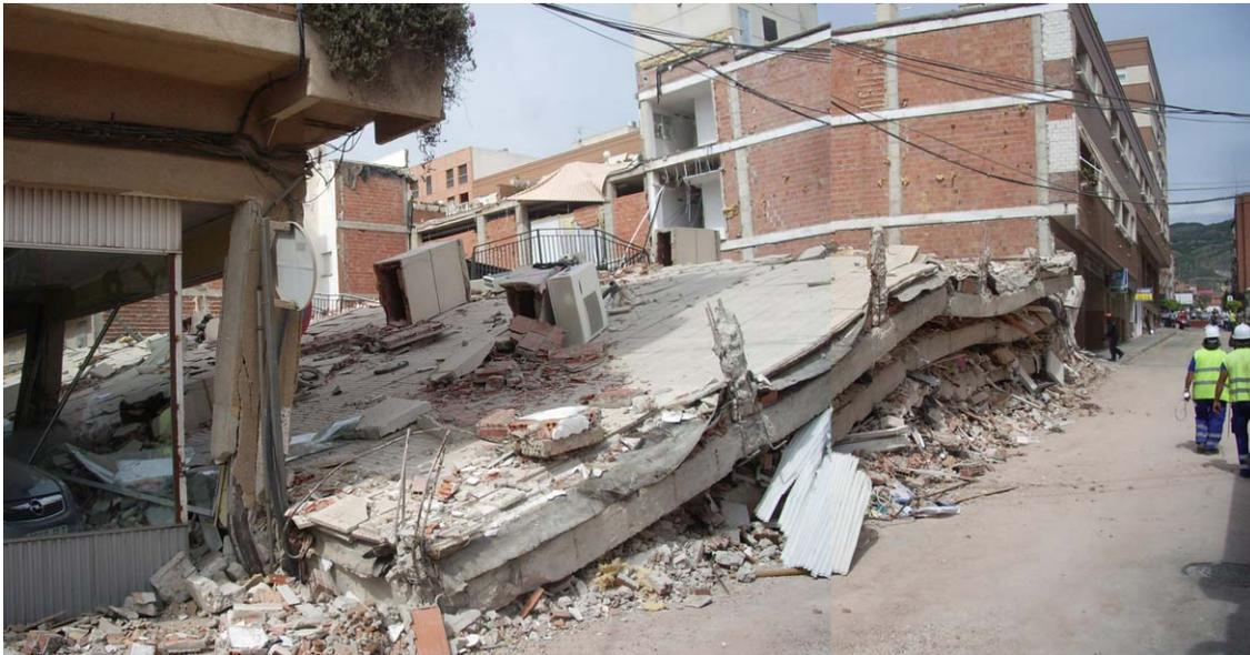
Fig B18 Detalle del encuentro pilar-forjado del edificio colapsado. Ver figura B6 para comprensión de un mecanismo inestable.
