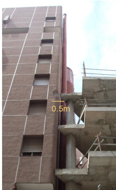
Fig B20 Daños por embestimiento en edificios de altura en Lorca.
