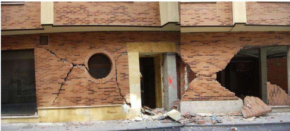
Fig B11 Daño frágil por cortante en cabezas de pilares de plantas bajas observados en varios edificios. Esto es un mecanismo inestable de daño de gran peligrosidad.
