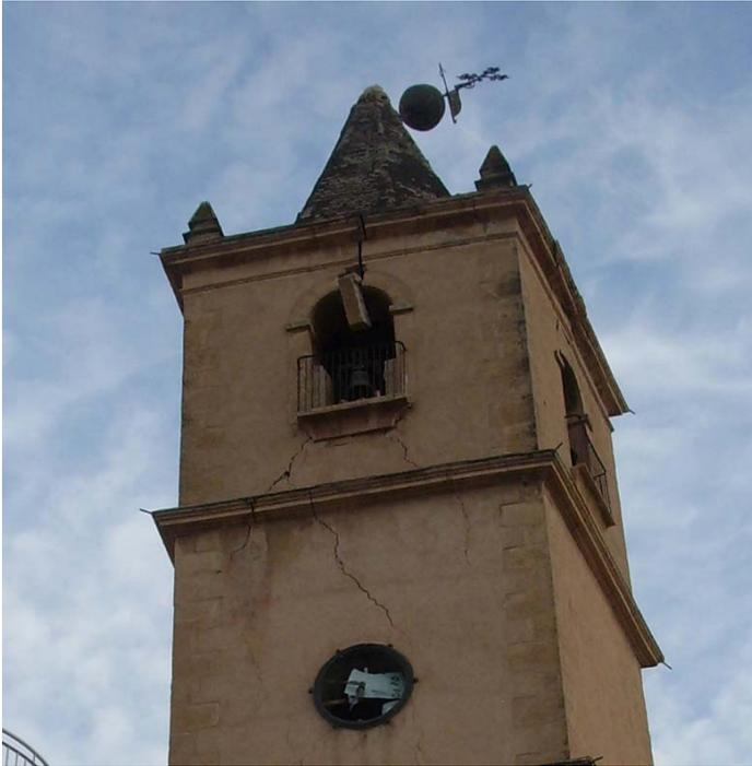
Fig B3 Deriva de muro de carga en torre medieval de la muralla
