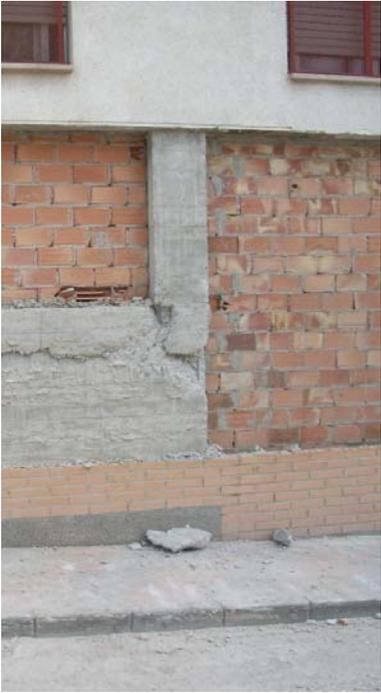
En la Calle Infante Juan Manuel nº 5 colapsó completamente un edificio de pórticos de Hormigón Armado de tres alturas. El edificio poseía una planta baja elevada con respecto de la rasante de la calle y pilares cortos en dos pórticos perimetrales. Un edificio gemelo colindante de la misma promoción (fig B13, izquierda) acusa graves deformaciones en los pilares cortos confirmando el mecanismo de colapso causado por el fallo de los pilares cortos perimetrales. (Figuras B14 – B17)
