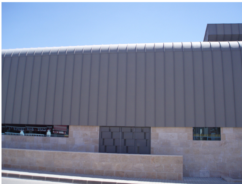
Figura 3.4.a Revestimiento de cubierta y parte de la fachada de un edificio con planchas de cinc en la actualidad
