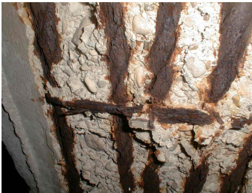
Corrosión de las armaduras de una viga tonel desprendimiento del hormigón de recubrimiento.
