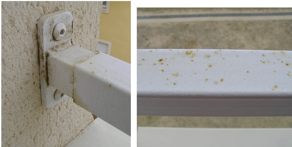
Ejemplo de referencia: Barandilla de acero con inicio de corrosión
