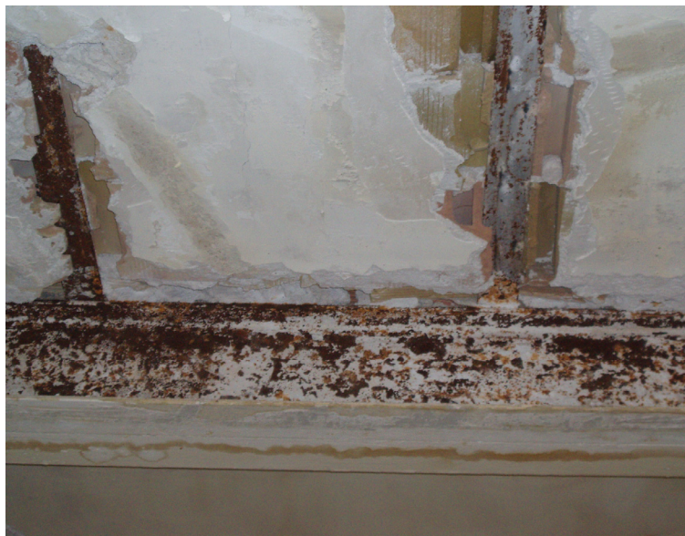
Fotografía 6.3 Filtraciones constantes de agua y corrosión intensa de los elementos metálicos de una estructura
