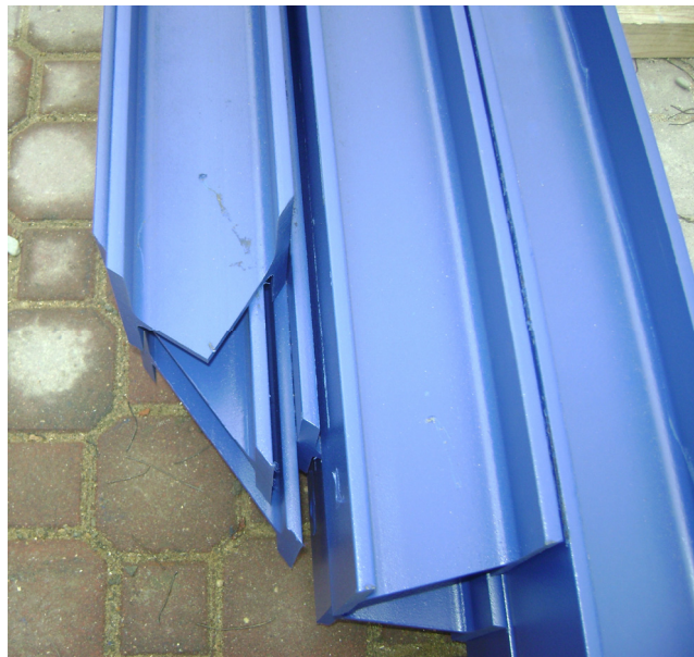
Figura 10.6.c Perfiles estructurales preparados para su montaje
