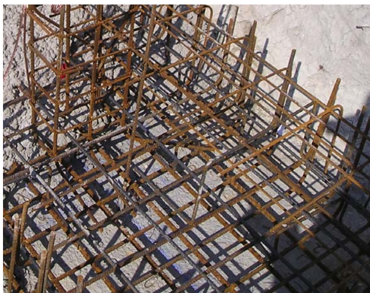
Figura nº 2.2.b La exposición de las armaduras a la intemperie ocasiona su corrosión de aspecto uniforme. Los tonos rojizos implican la formación de óxido férrico.
