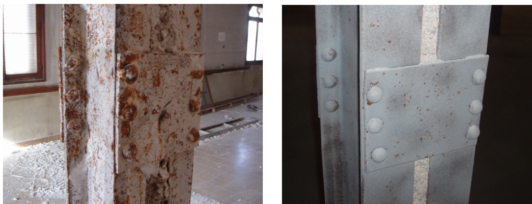
Figura 10.6.b Elemento metálico antes y después del tratamiento superficial
