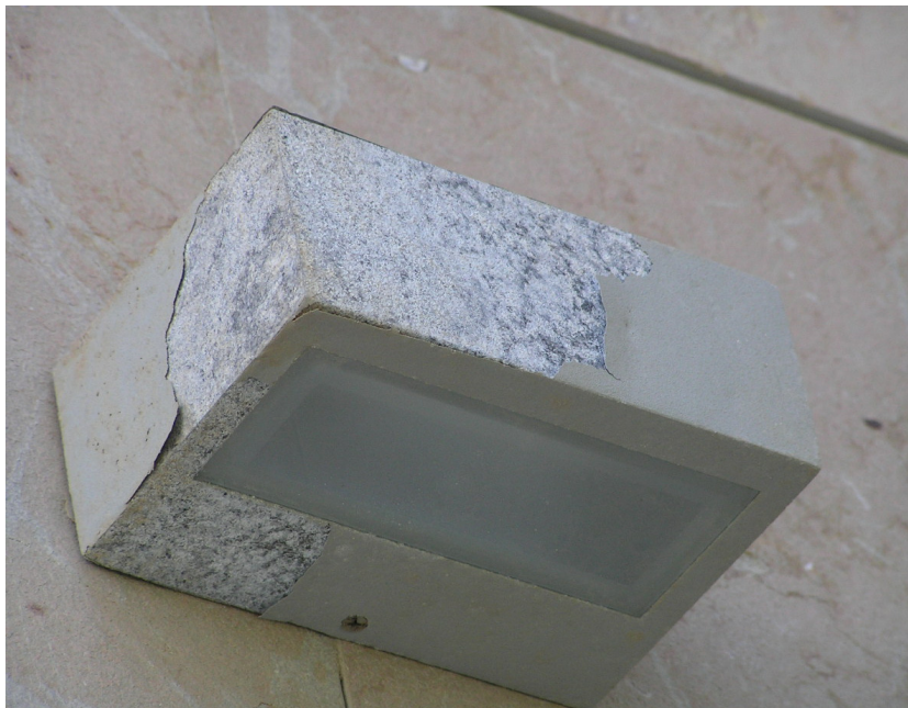
Ejemplo de referencia: Luminaria ubicada en la fachada de una vivienda costera
