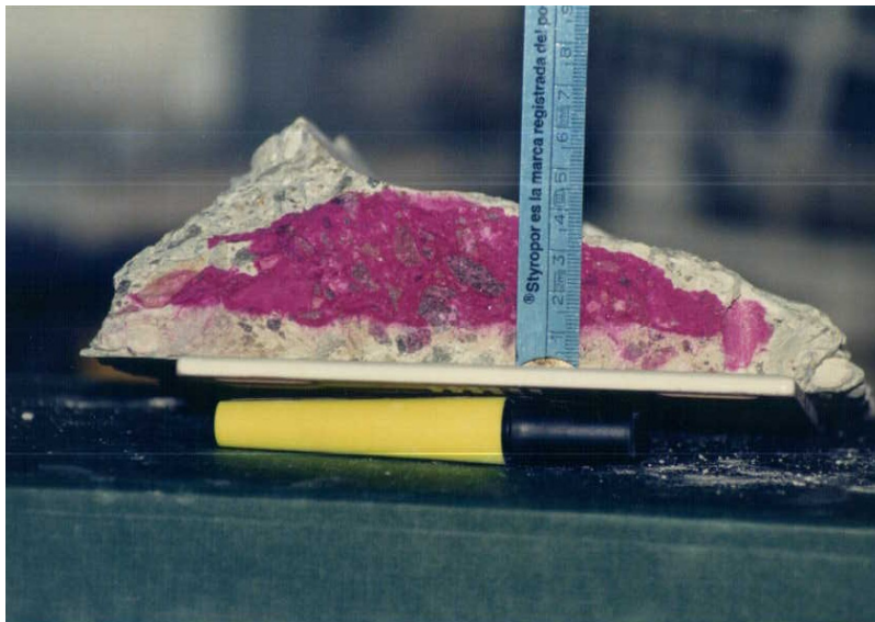
Figura 9.4.1.2.a Se puede apreciar la costra carbonatada del hormigón de más de un centímetro de espesor. El núcleo permanece con carácter básico la fenolftaleína vira al rojo-violeta.
