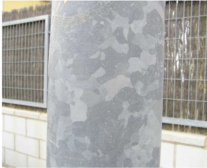
10.5.1 Fuste de una farola galvanizado con el clásico efecto del “floreado”. Obsérvese ciertas acumulaciones de cinc, en la parte superior propias de un proceso de inmersión en caliente.
