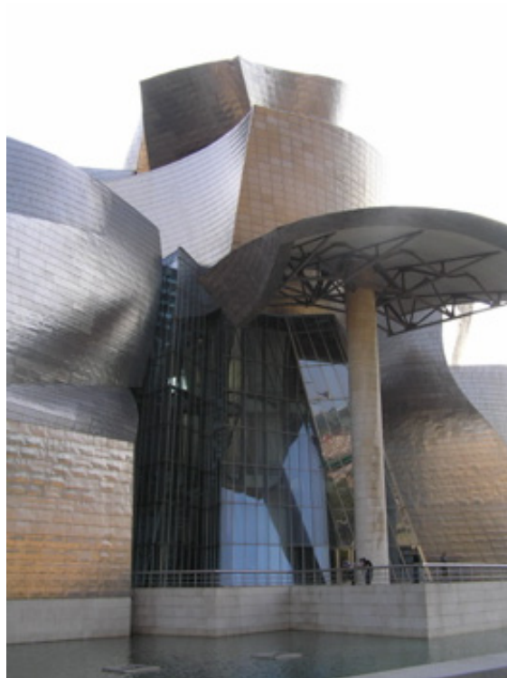
Figura 3.6.a. Planchas de titanio en la fachada del museo Guggenheim de Bilbao
