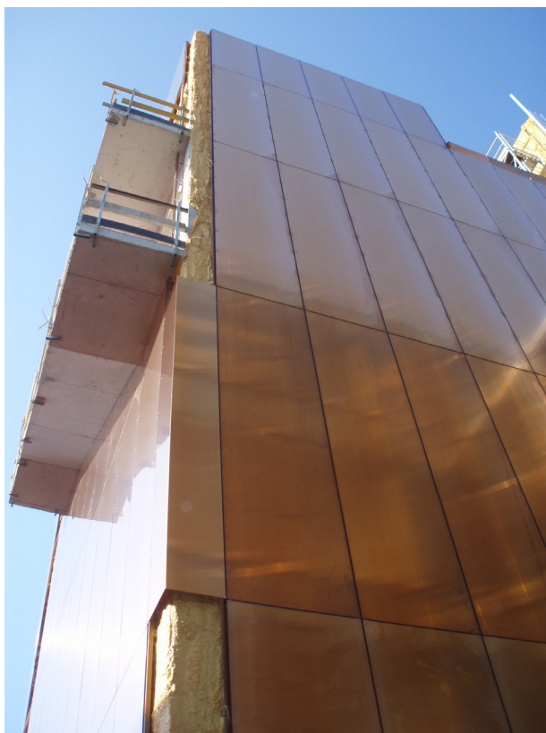
Figura 3.3.a Fachada de un edificio en construcción con placas de cobre
