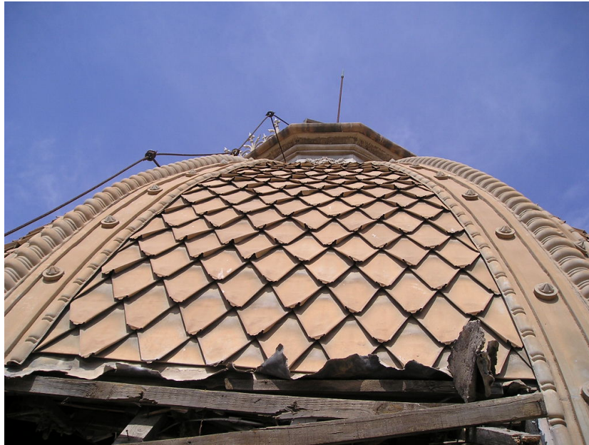
Figura 3.4.b Cúpula recubierta de planchas de cinc.
