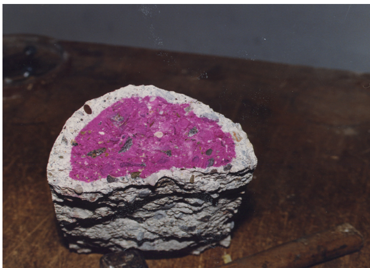
Figura 5.1.a Capa carbonatada en un fragmento de hormigón
