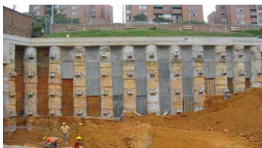
Fig. 16 Pantalla discontinua anclada
