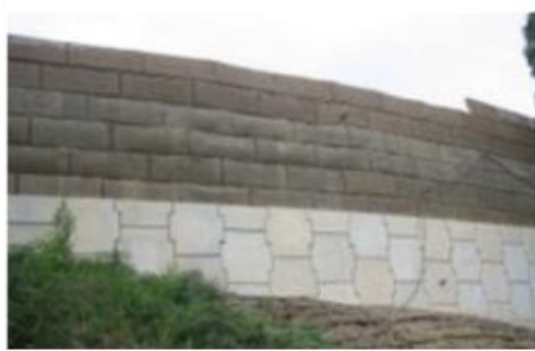
Fig. 20 Muro de tierra Armada
