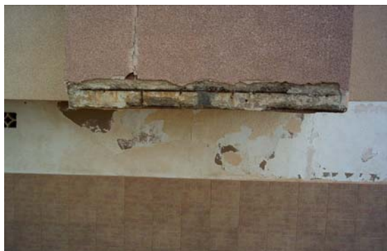
Fig. 05 Proceso de corrosión de armado
