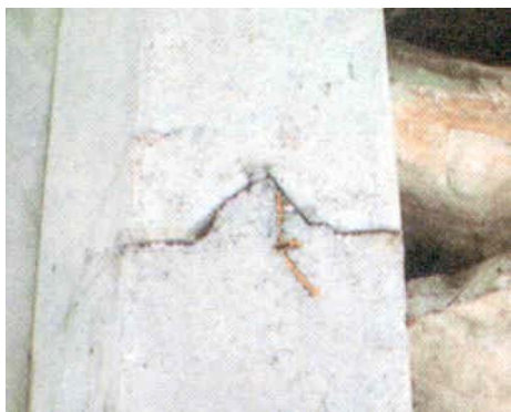
Fig. 26 Cinta mal colocada
