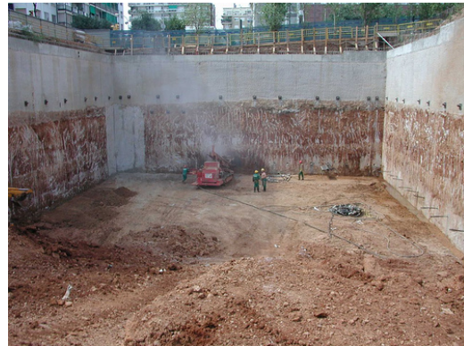
Fig. 17 Muro Pantalla
