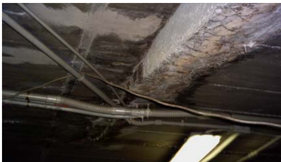
Fig. 09 Daños en sótano por falta de impermeabilidad
