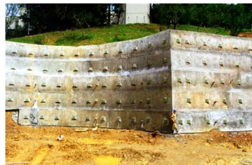
Fig. 19 Anclaje en muros
