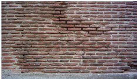
Fig. 04 Pérdida de calidad por ciclos humectación-secado
