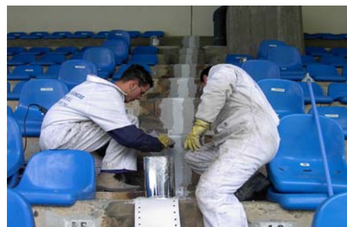
Fig.29 Tratamiento de junta mediante sistema elástico de banda preformada y resina epoxi de anclaje
