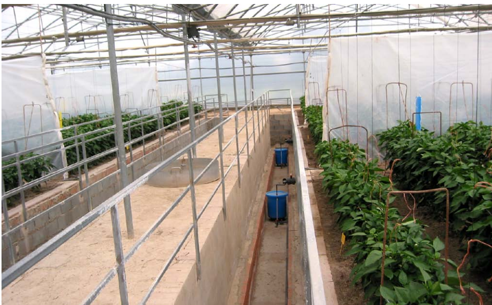
Foso de recogida de lixiviados y separación con mamparas de los distintos tratamientos.
